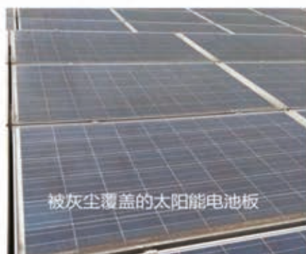
图 1：受灰尘覆盖影响的太阳能电池板及对应的汇流箱电流值
